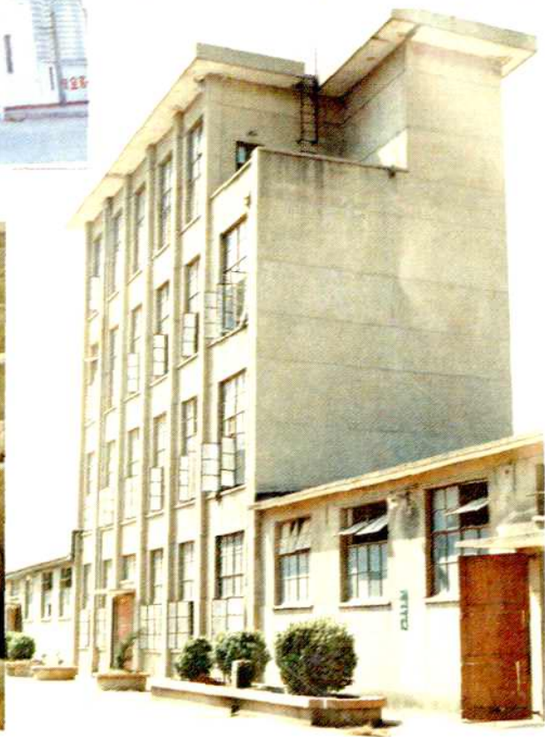
26. 徐州面粉厂配合饲料车间
