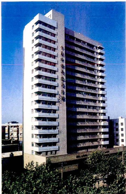
杭州中国水稻研究所高层住宅
