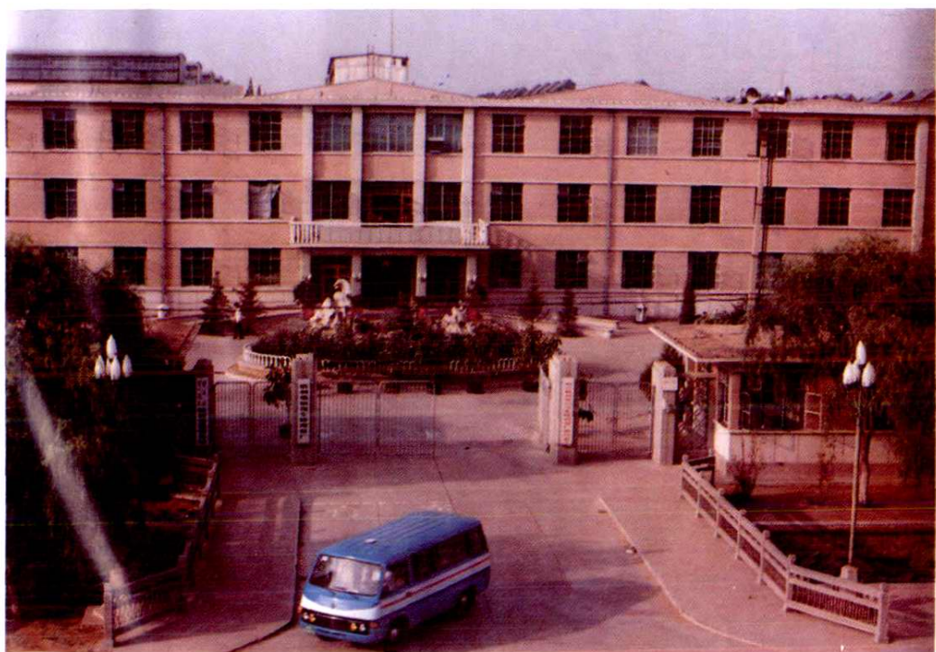
汽修总厂办公大楼
