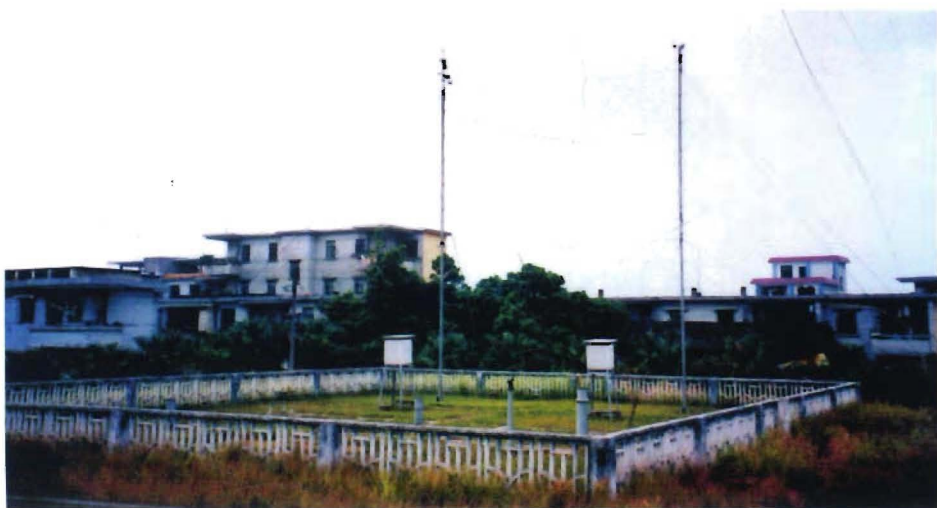
1998 年英德县气象局地面气象观测场全貌
