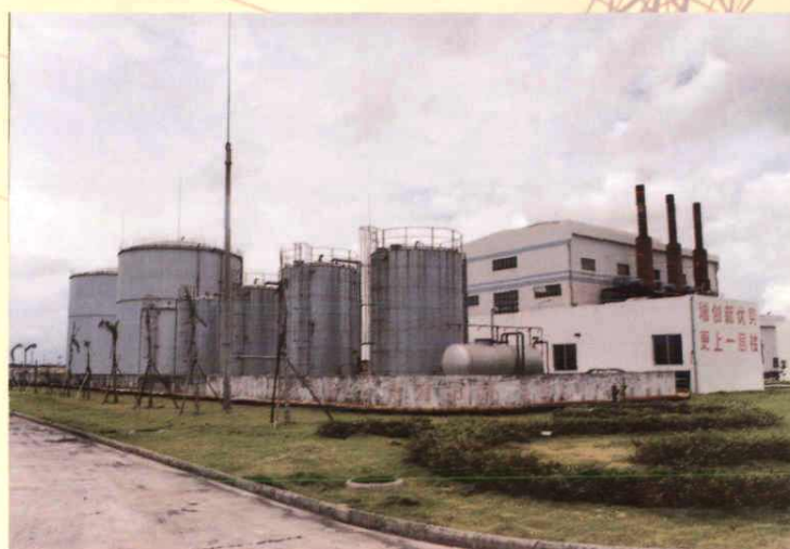
陆丰东港火力发电厂，装机容量 3 \times 1 万千瓦，图为火电厂厂房。
