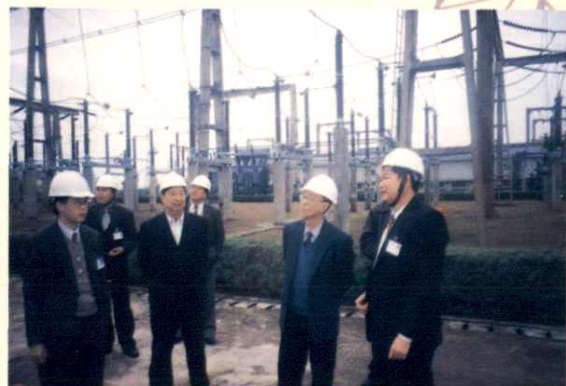
2000年3月，原广东省电力局副局长张毓麟（右二）到汕尾电力局检查工作，图为在桂竹220KV变电站了解变电安全运行情况。
