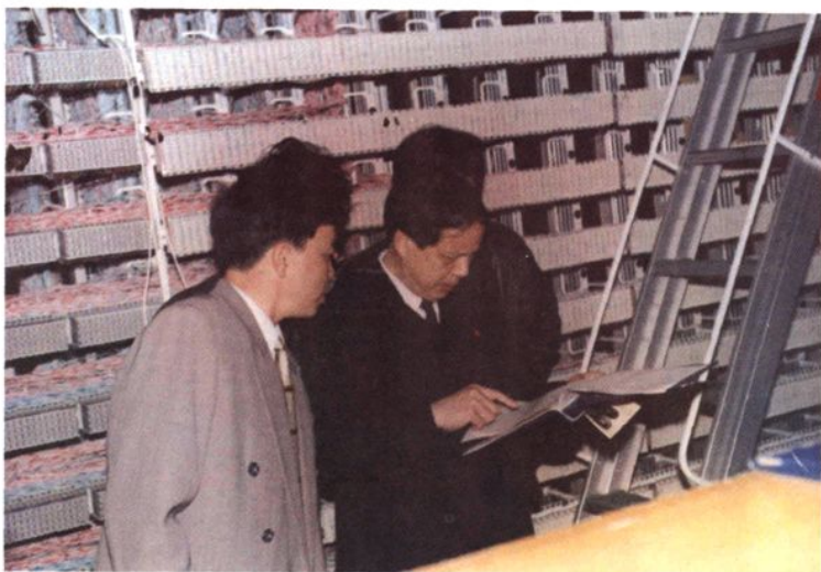
省局杨理正副局长 在机房检查管理工作 ▶
