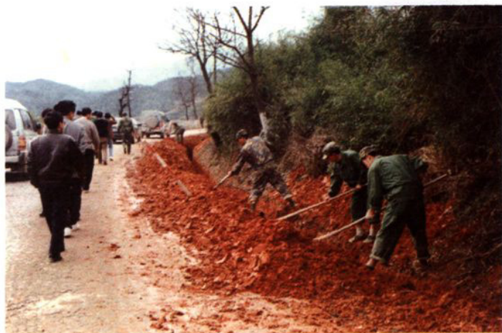
部队在为敷设通信光缆紧张工作 ▲
