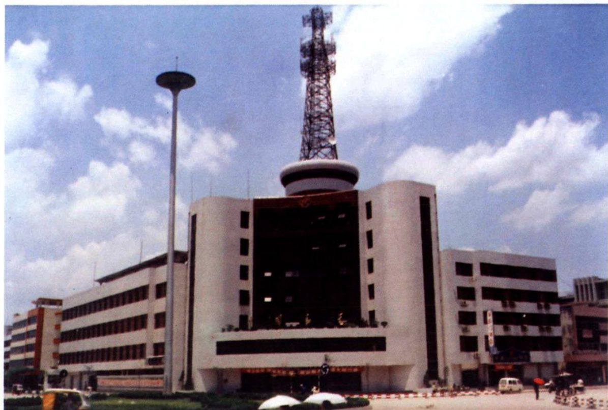
浦城县邮电大楼
