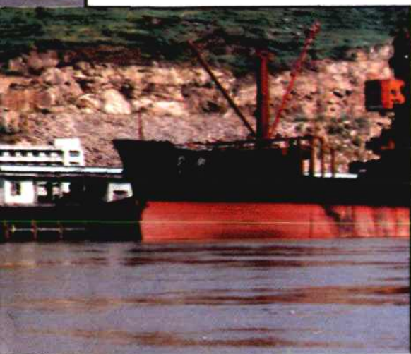
万吨级卸煤专用码头
