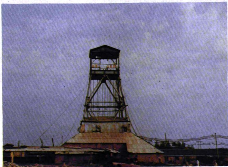
1976年在兴隆庄煤矿东风井创月进161.54米的全国冻结表土段施工新记录。图为东风井井口
