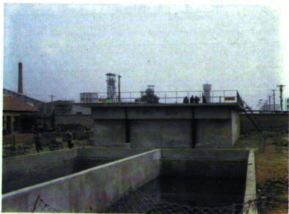
正在建设中的 杨村煤矿环保 工程
