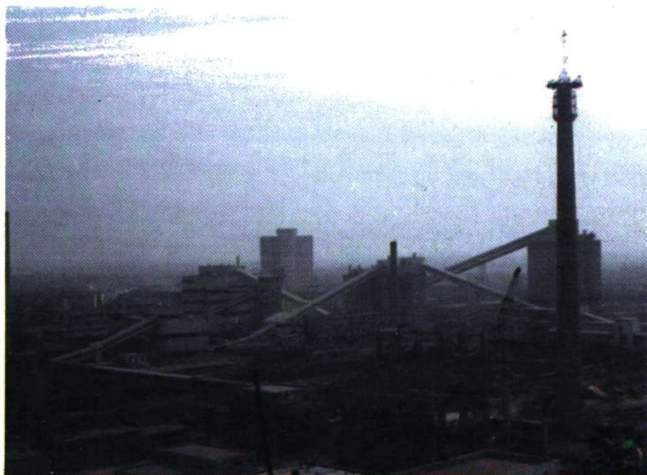
兴隆庄矿原煤生产系统
