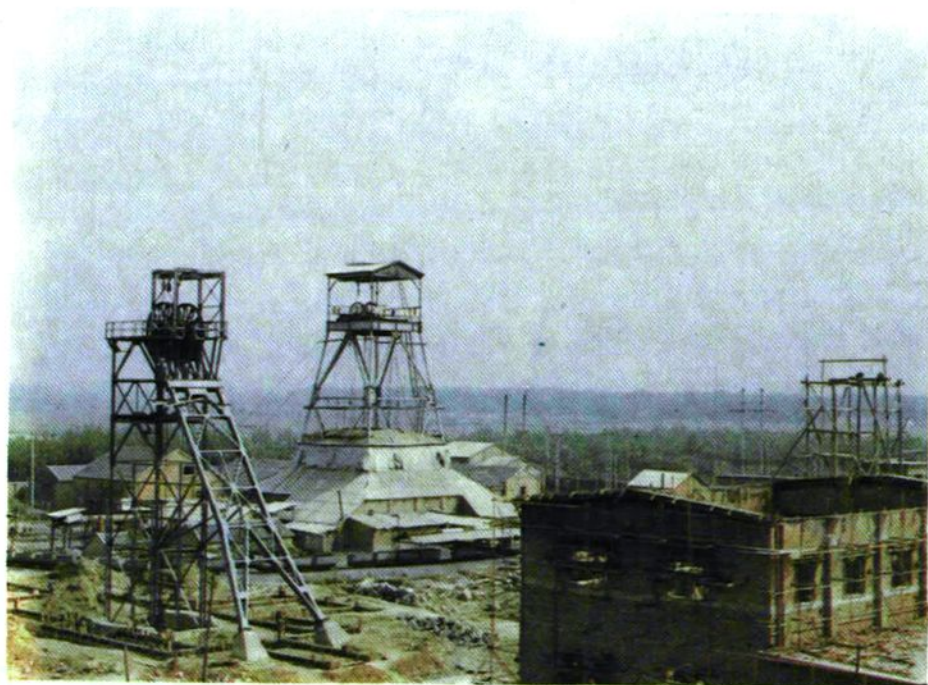
正在建设 中的杨村煤矿
