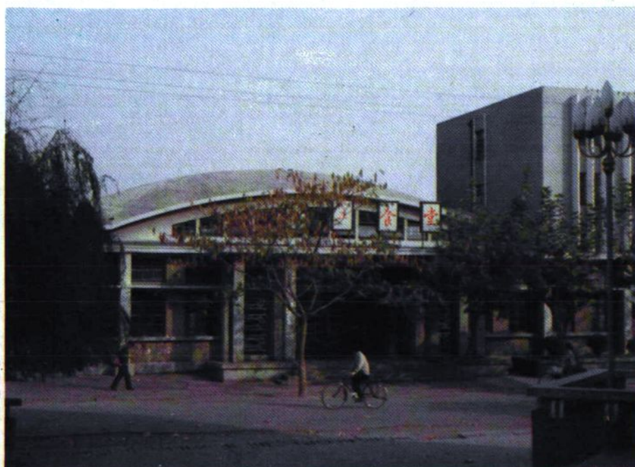
土建工区建设的兴隆庄煤矿第二职工食堂
