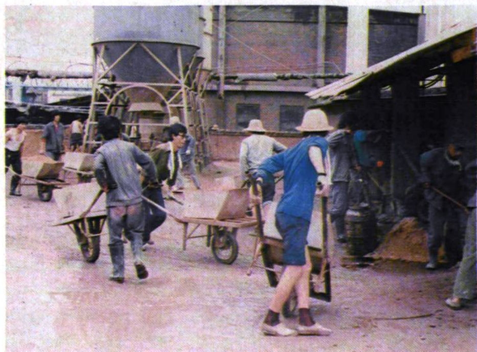
机关干部在施工现场参加劳动
