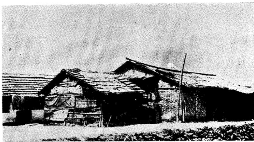
解放初期船民住宅 (现用作储藏杂物)
