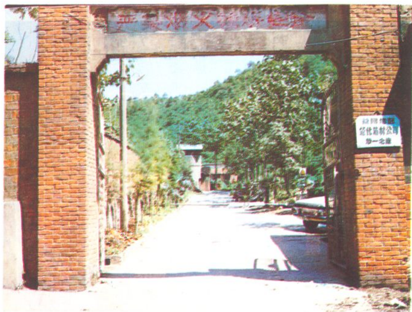
◀ 第一仓库（危库）外貌
