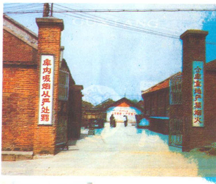
第二仓库（综合库）外貌 ▶
