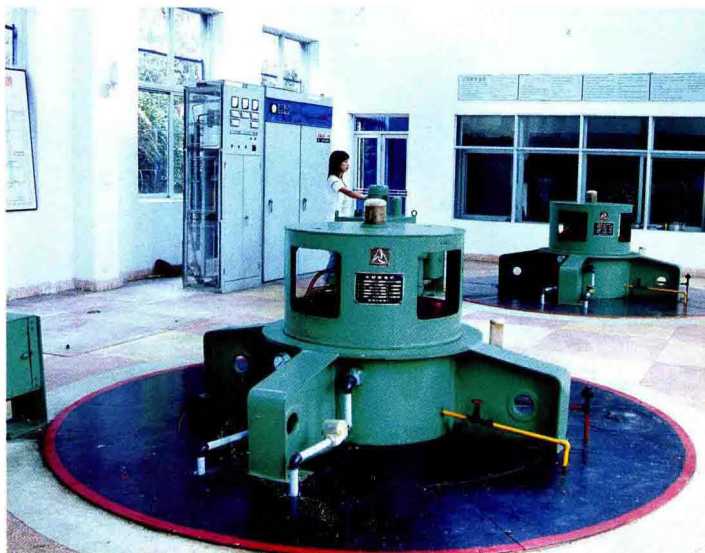
姜山头水电站的立式水轮发电机组
