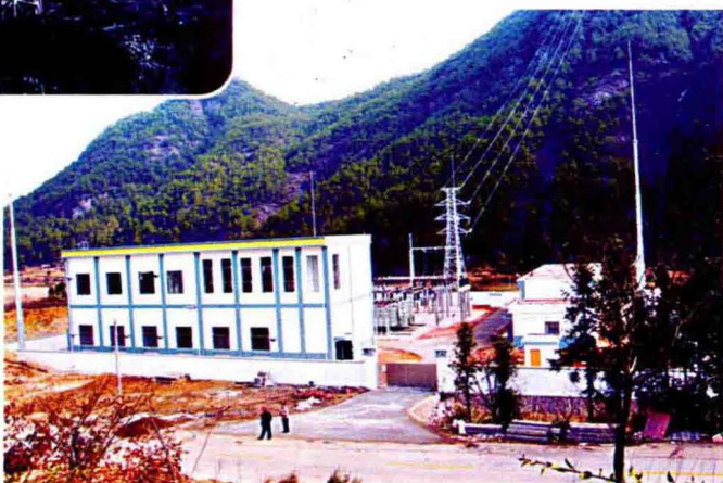
新建的 110 千伏冷水变电所
