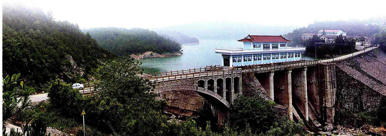
五丈岩一级水电站拦河大坝
