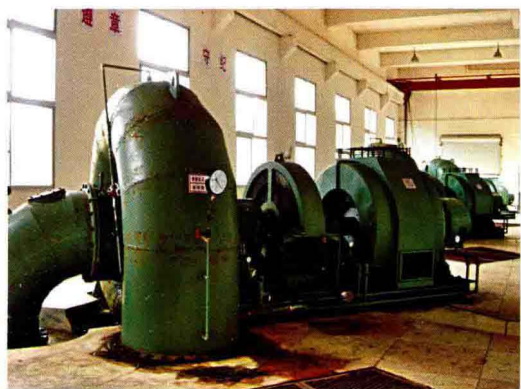
双溪水电站的卧式水轮发电机组
