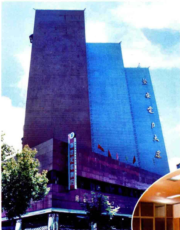
磐安县供电局电力调度 综合大楼
