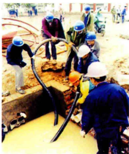
1998 年整改城网时,电力职工在 县城城中路敷设地下电缆
