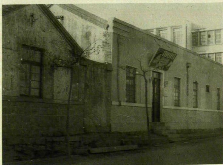
昆崙中心邮电局局址
