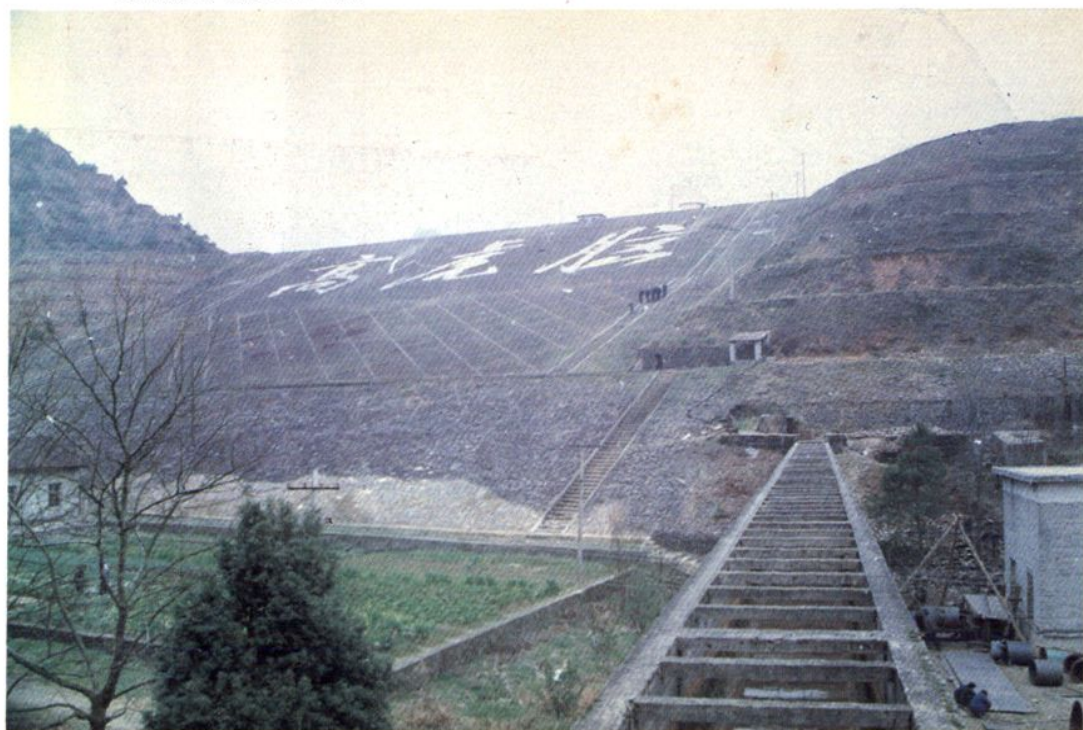
高虎脑水库大坝全景
