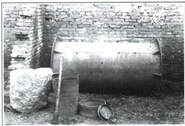
● 安县水泥厂试产的原始设备：石碓窝，铁碓窝，简易磨机和大小丝罗（一九六九年）
