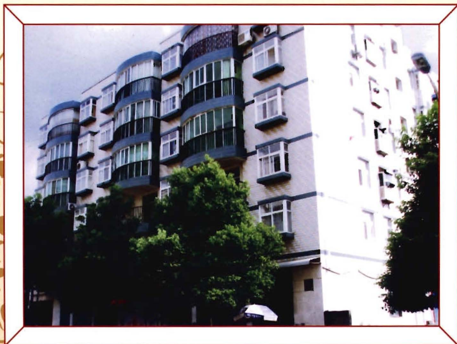
溢水工商所办公楼
