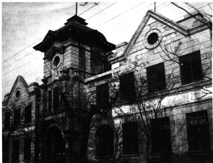
1912.8—1928年中国银行总行(总管理处)办公楼旧址
