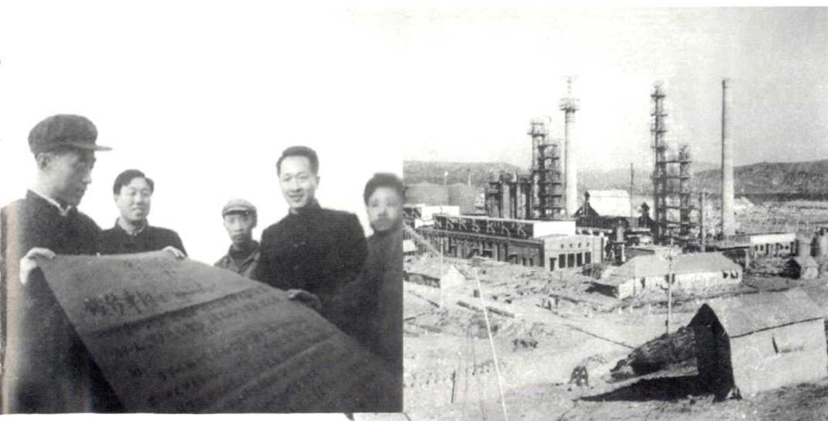
1964年第一套生产装置—热裂化装置正在建设
