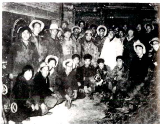
1965年1月25日下午，第一台锅炉点火成功，厂领导与干部工人合影。
