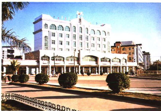
东兴市邮政局新建综合楼
