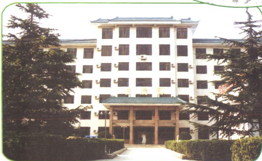
▲ 一九九六年建成的8200m 2 病房楼。
