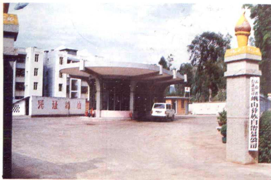
石油公司加油站一角
