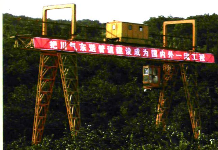
红花套天然气换流站施工现场（2006年摄）
