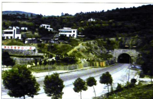
松木坪麻岭坳隧道 (2006年摄)
