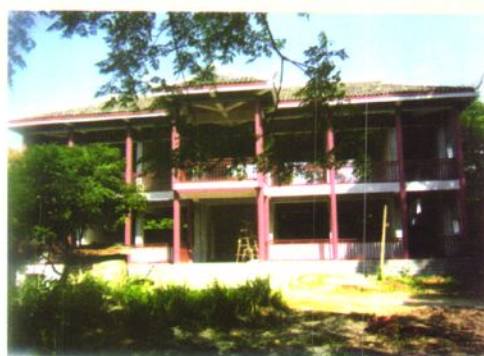
正在建设中的龙大道烈士陵园陈列馆
