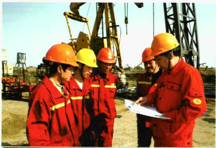
作业公司领导在施工现场部署修井任务
