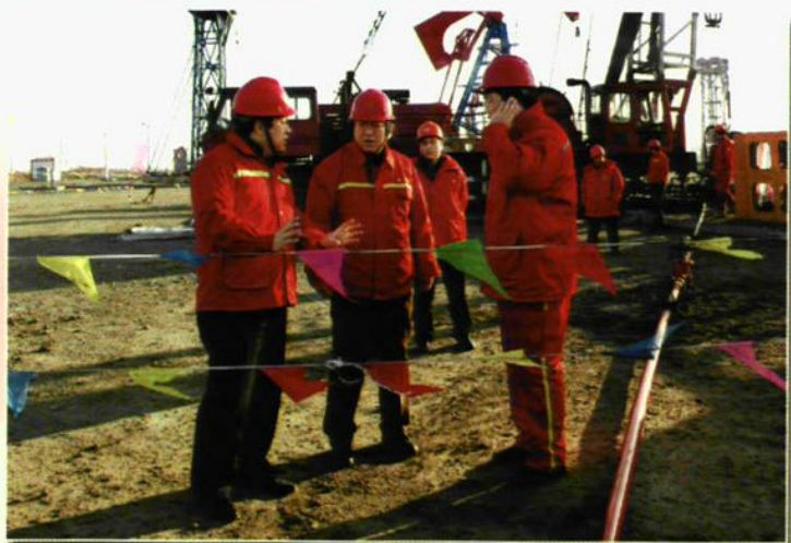
吴兴林处长在冬季施工现场检查指导工作
