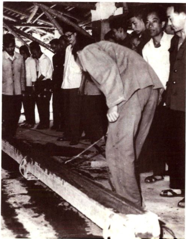
▲ 1963年7月，余杭县广播管理站自力更生生产广播专用水泥杆
