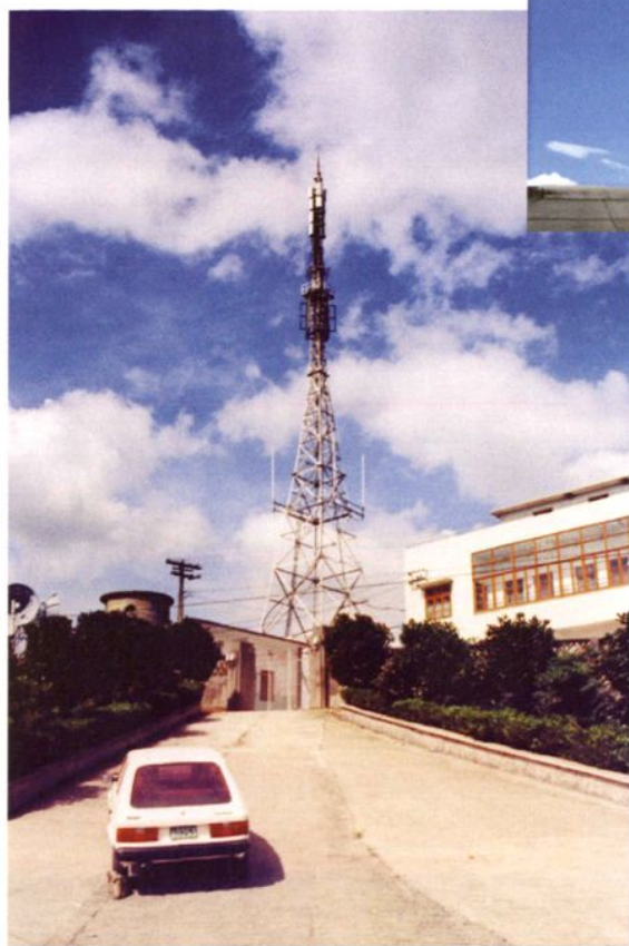
▲ 1985年7月，余杭电视台临平山发射台
