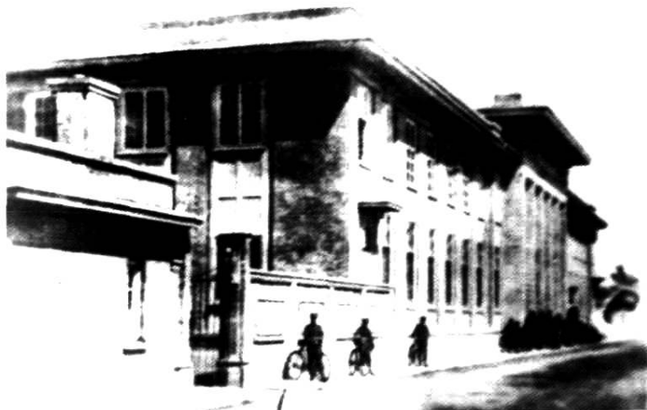
民国16年（1927年）落成的城站浙江邮务管理局自建局屋；1950年12月1日移杭州邮局使用。
