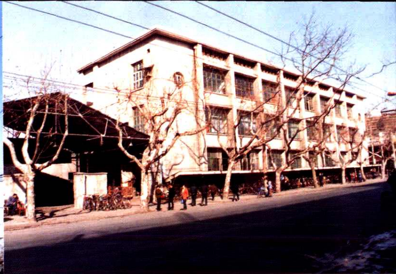
杭州市邮政局生活楼外貌
