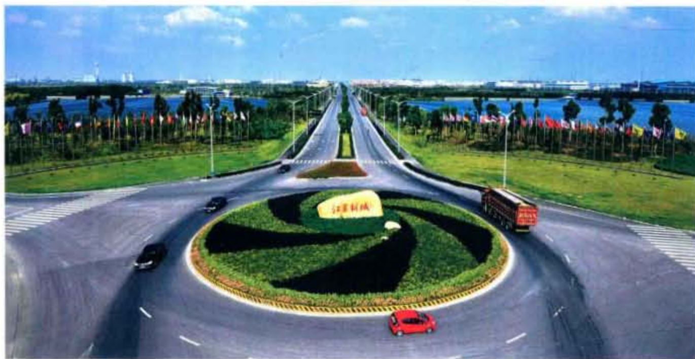
杭州江东工业园区（2010年摄）
