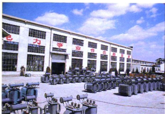
杭州錢江變壓器廠
