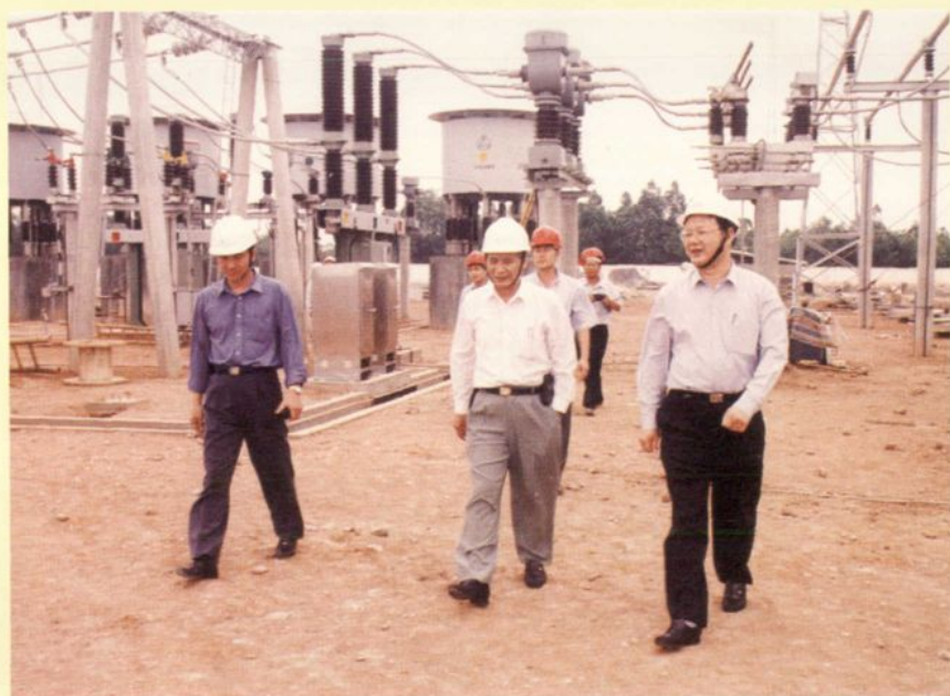
省电力集团公司董事长吴希荣（右一）在茂名电力局局长蒋礼强（右二）陪同下到500KV茂名变电站检查指导工作
