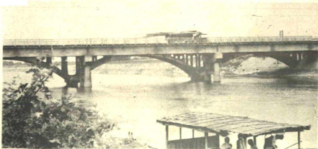
图为赵家（改建，新建）公路大桥掠影。新建桥长95.76米，净宽7米，三孔，装配式预应力钢筋混凝土结构，载重量为汽——20（吨）拖挂——220（吨）。谢小成 摄
