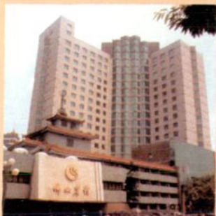
佛山宾馆工程实例
