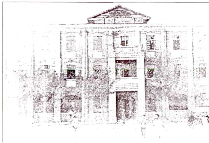
1927年沪杭甬铁路总工会会址。
