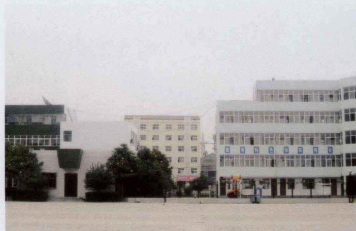
圣源学校教学楼
