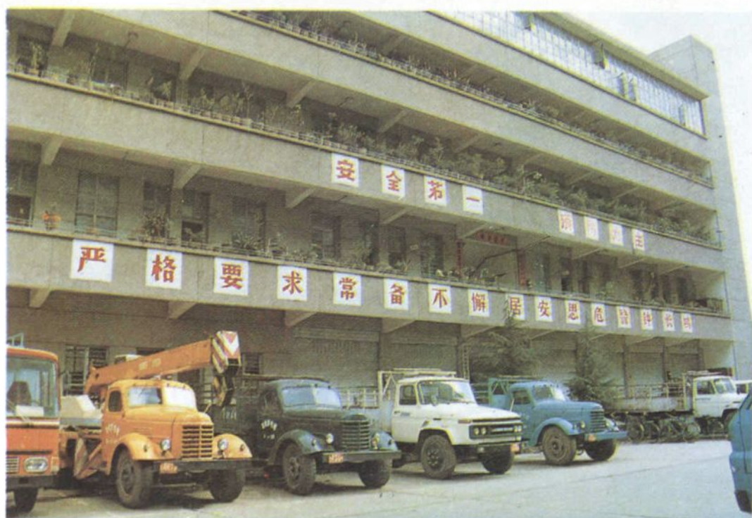
配电管理所办公大楼
