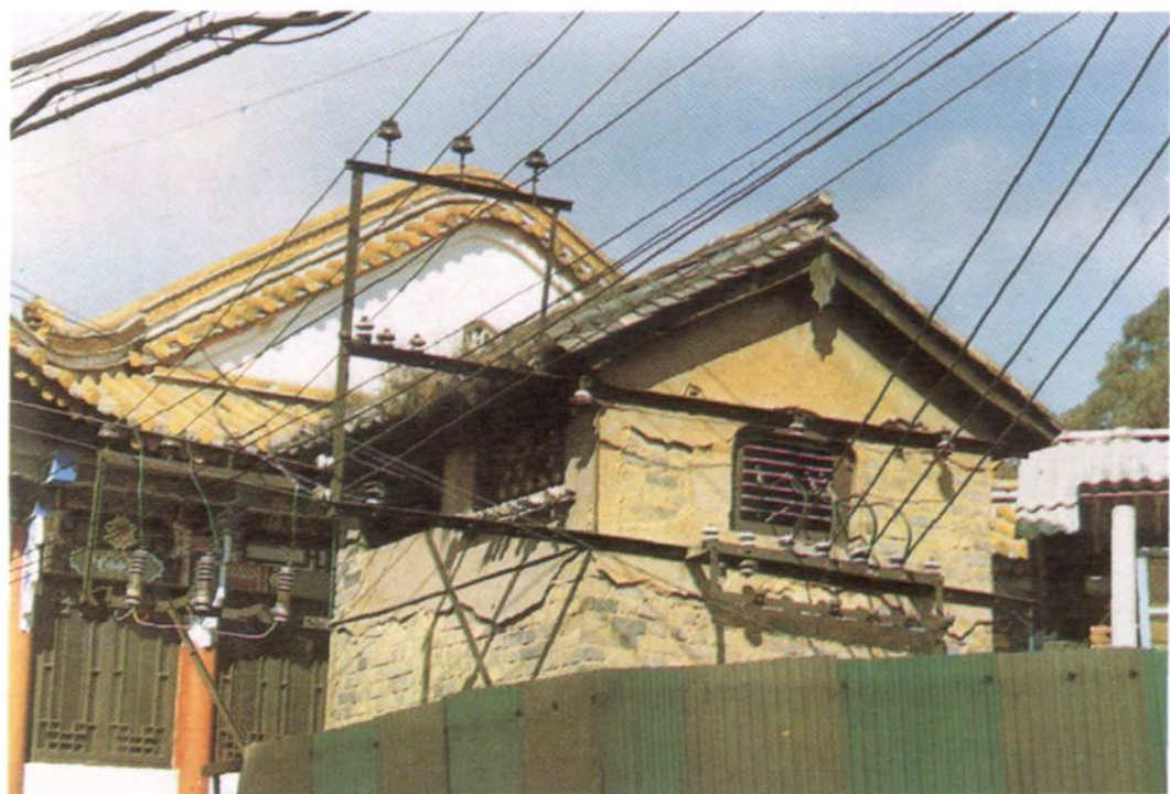
30 年代文庙配电室旧址
