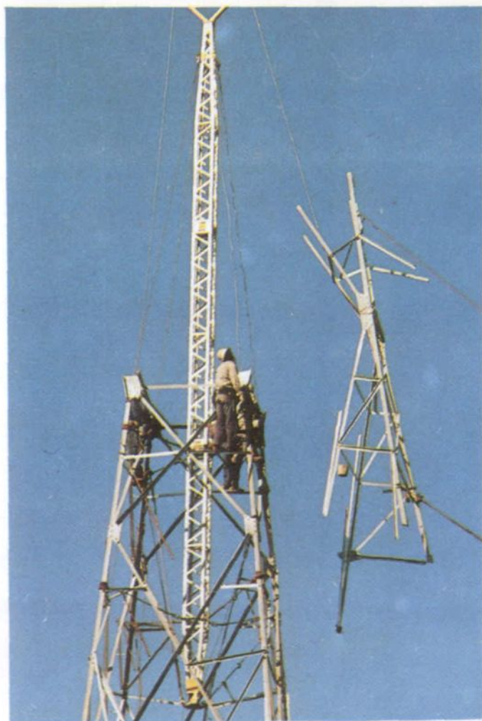
输电铁塔组装
