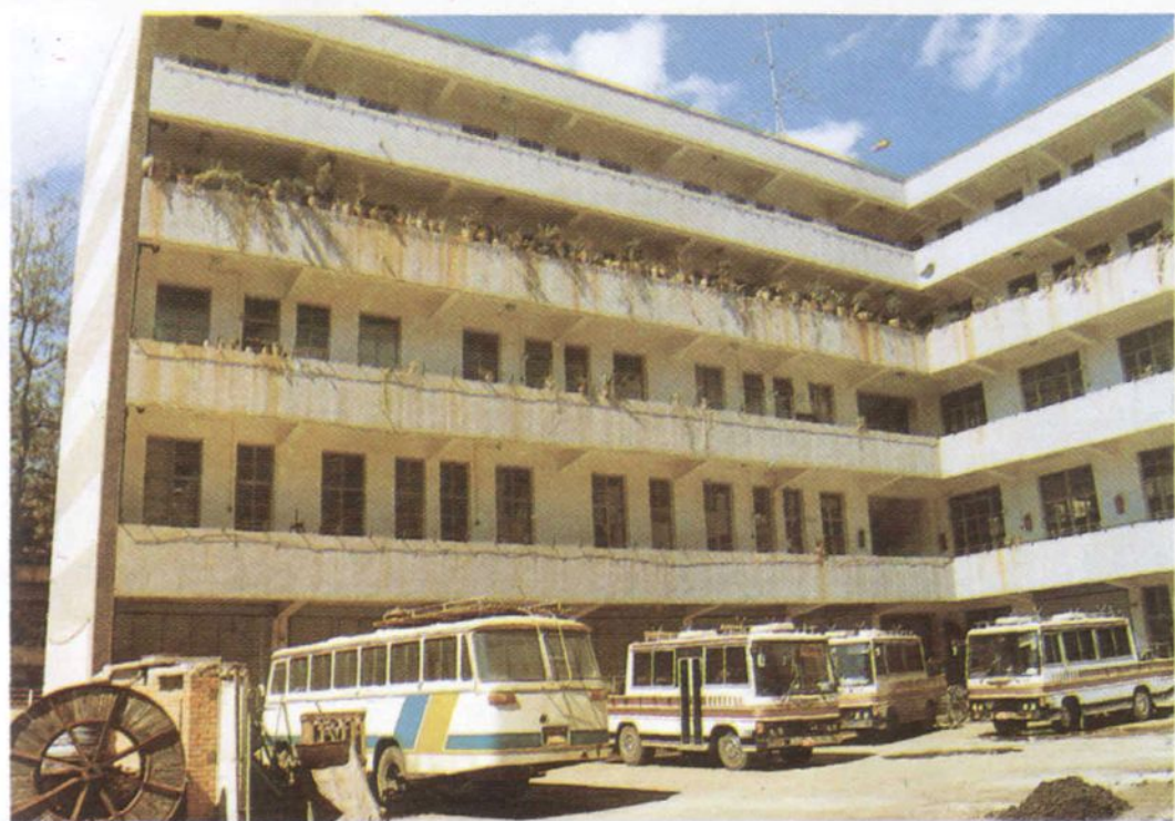
输电管理所 办公大楼
