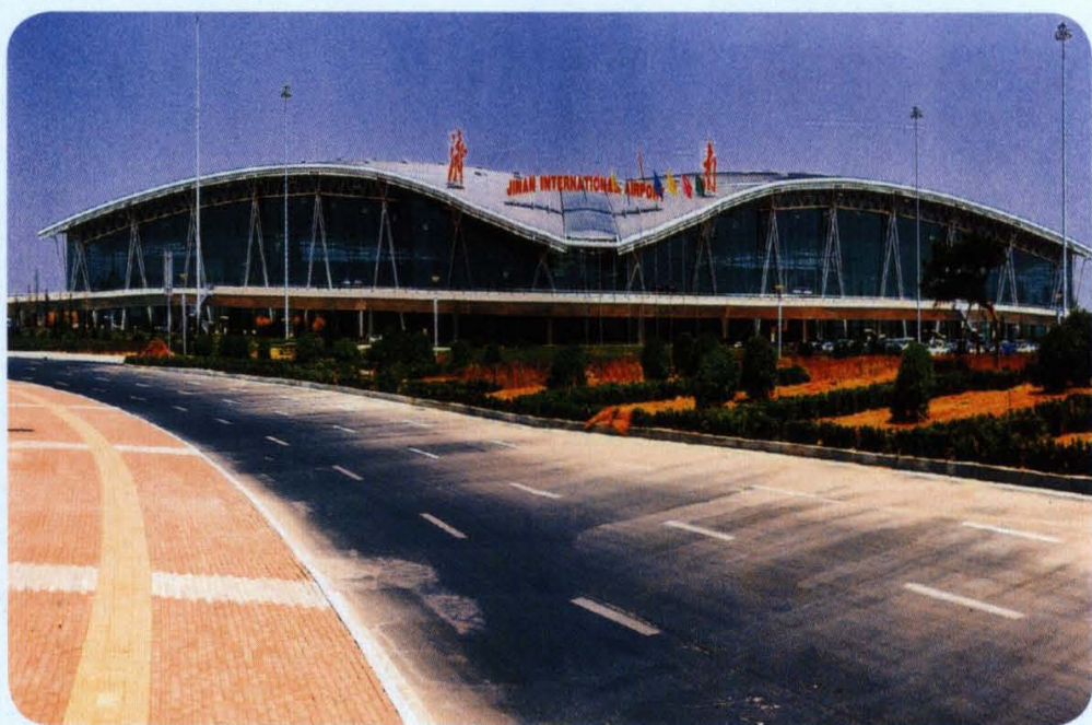
济南国际机场候机楼
