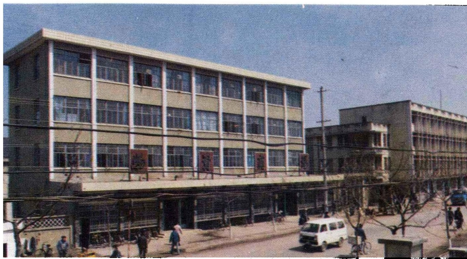
江宁县物资局办公大楼
