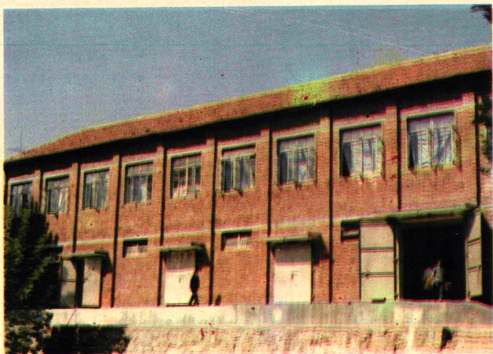
阳新县对外经济贸易局综合仓库
