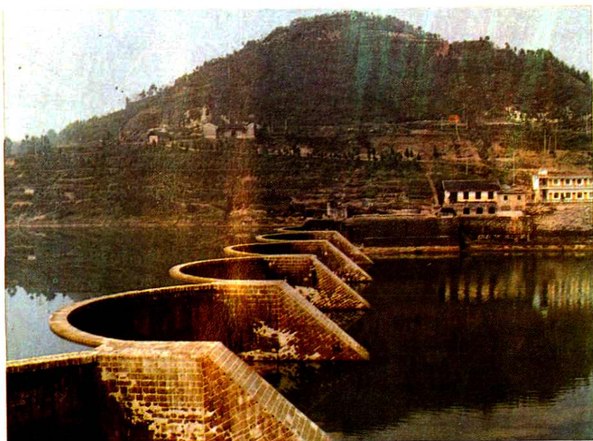
玉龙漏水垭坝首电力提灌站
