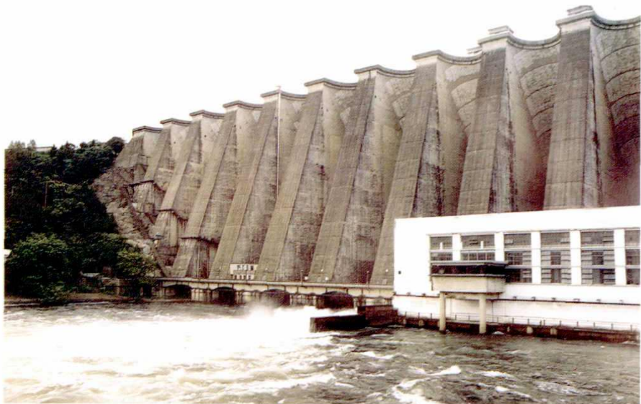
九号拱泄水底孔开启为史河灌区提供灌溉用水。
