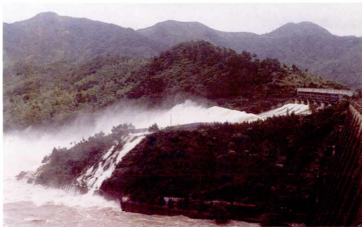
1991年7月，水库遭遇特大洪水。图为溢洪道和泄洪隧洞同时泄洪。
