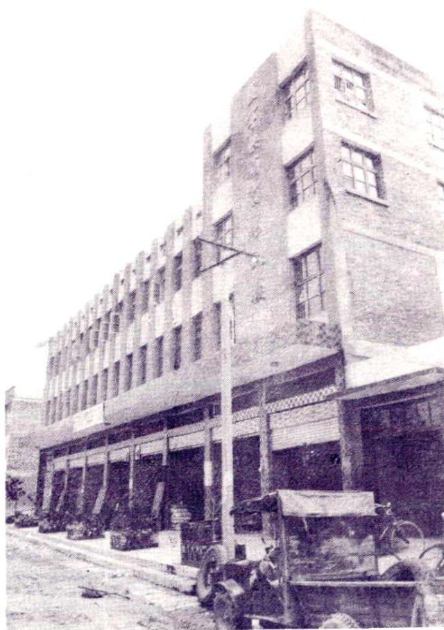
县综合贸易公司武阳贸易大楼
