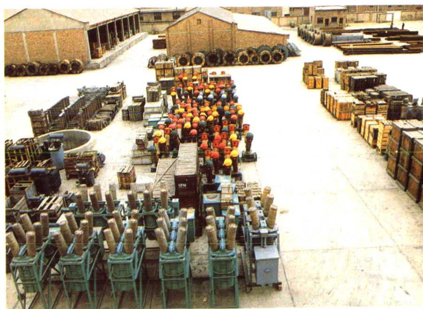
兰州供电局中心仓库一角
