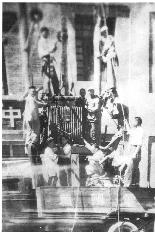
解放初期兰州电厂工人正在更换变压器
