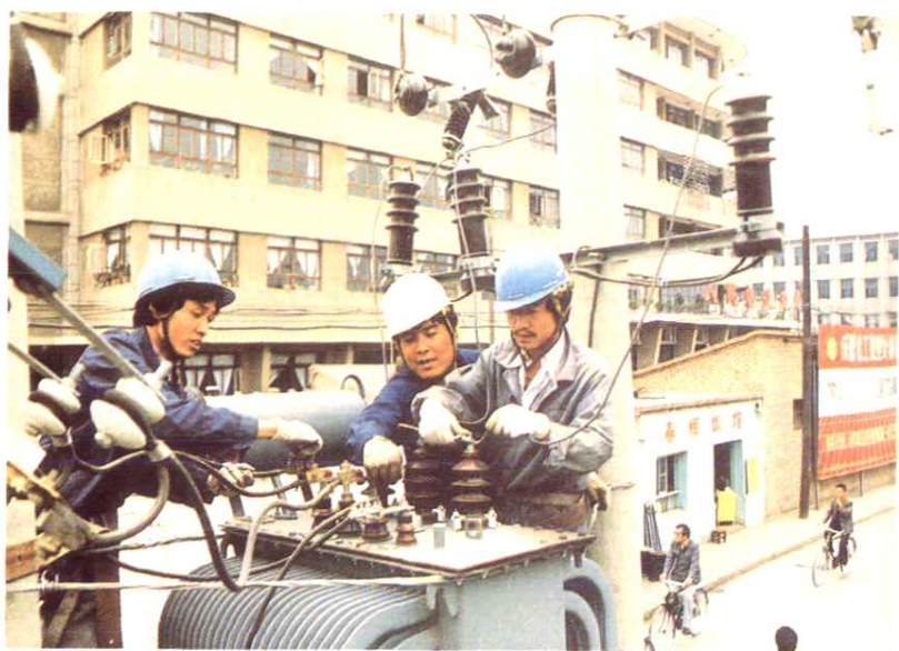
配电检修工人正在工作
