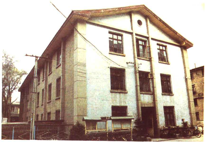
原野猪湾局办公大楼
