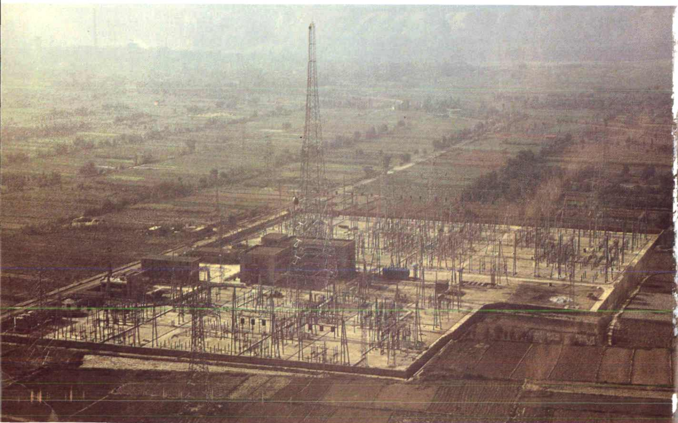
海石湾330千伏变电站
