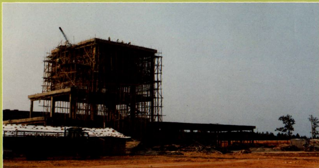
△建设中的中密度纤维板厂车间
