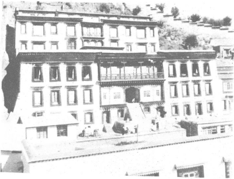
图 19 西印经院主体建筑外景
