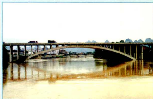
金宜一级公路怀远特大桥
