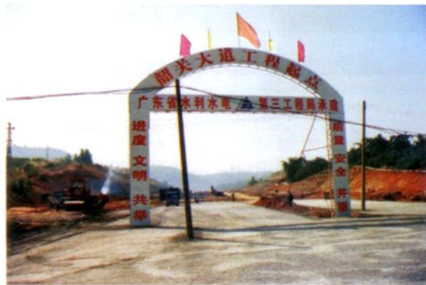
正在兴建中的韶关大道
