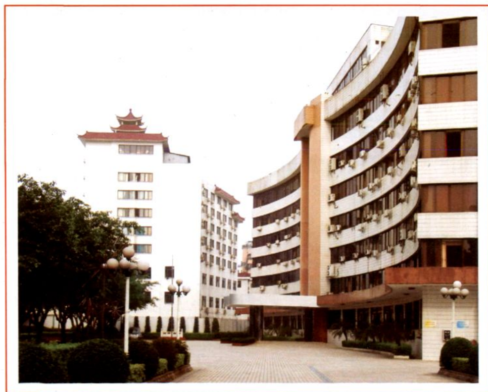
区机关办公楼
