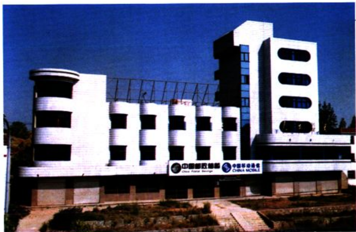
河口邮政电信大楼
