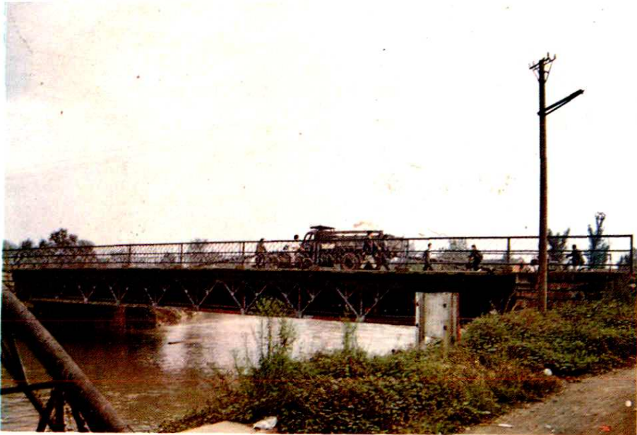
洞子口乡钢架桥
