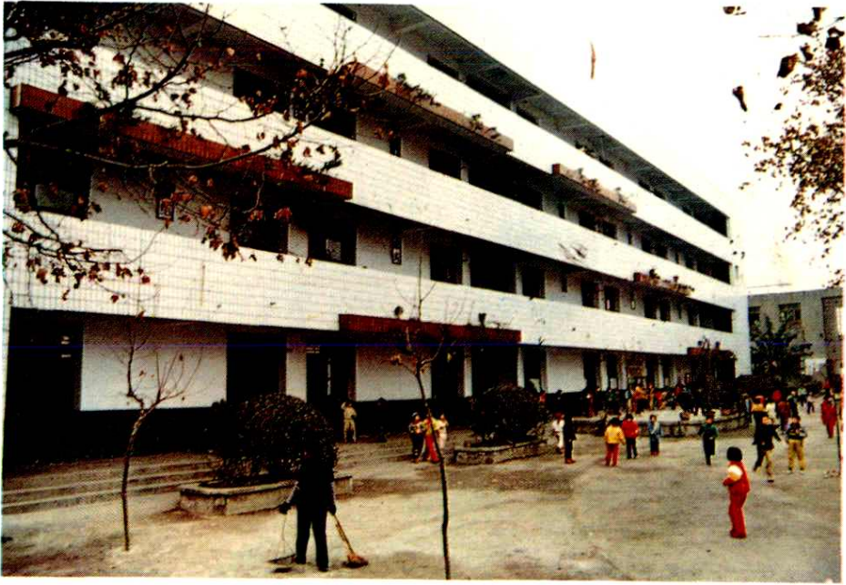
洞子口乡中心小学教学大楼
