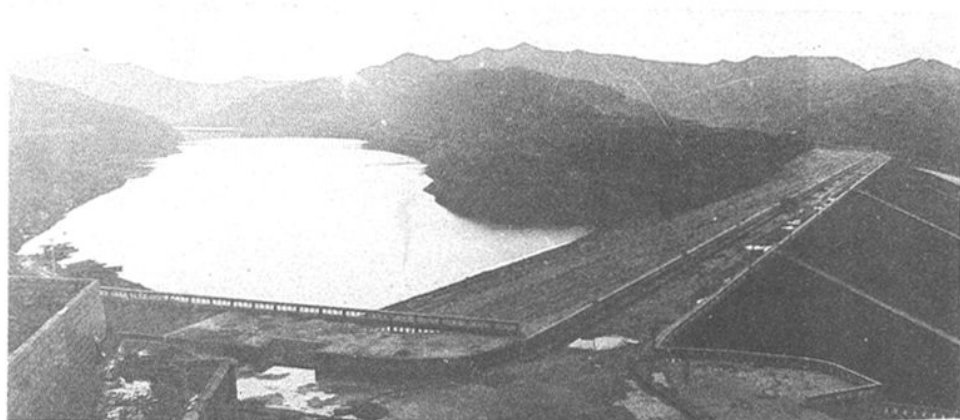
升钟水库大坝
