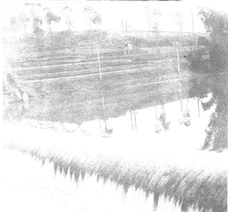
自贡市釜溪河橡胶坝。
