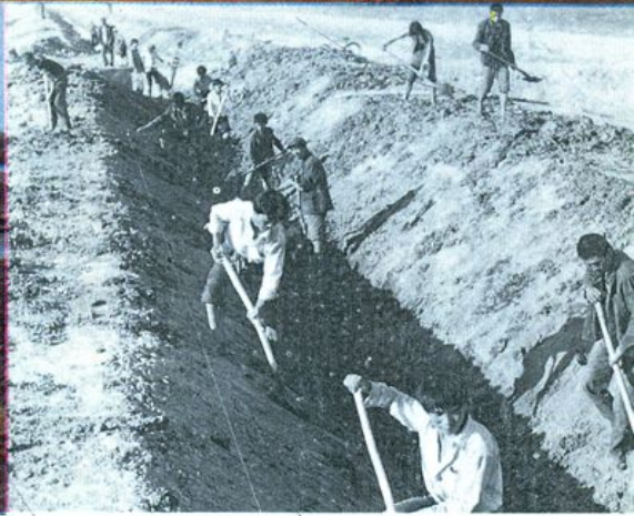
五堆子乡新修渠道
