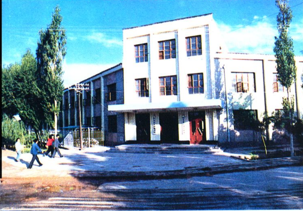
水电局办公楼
