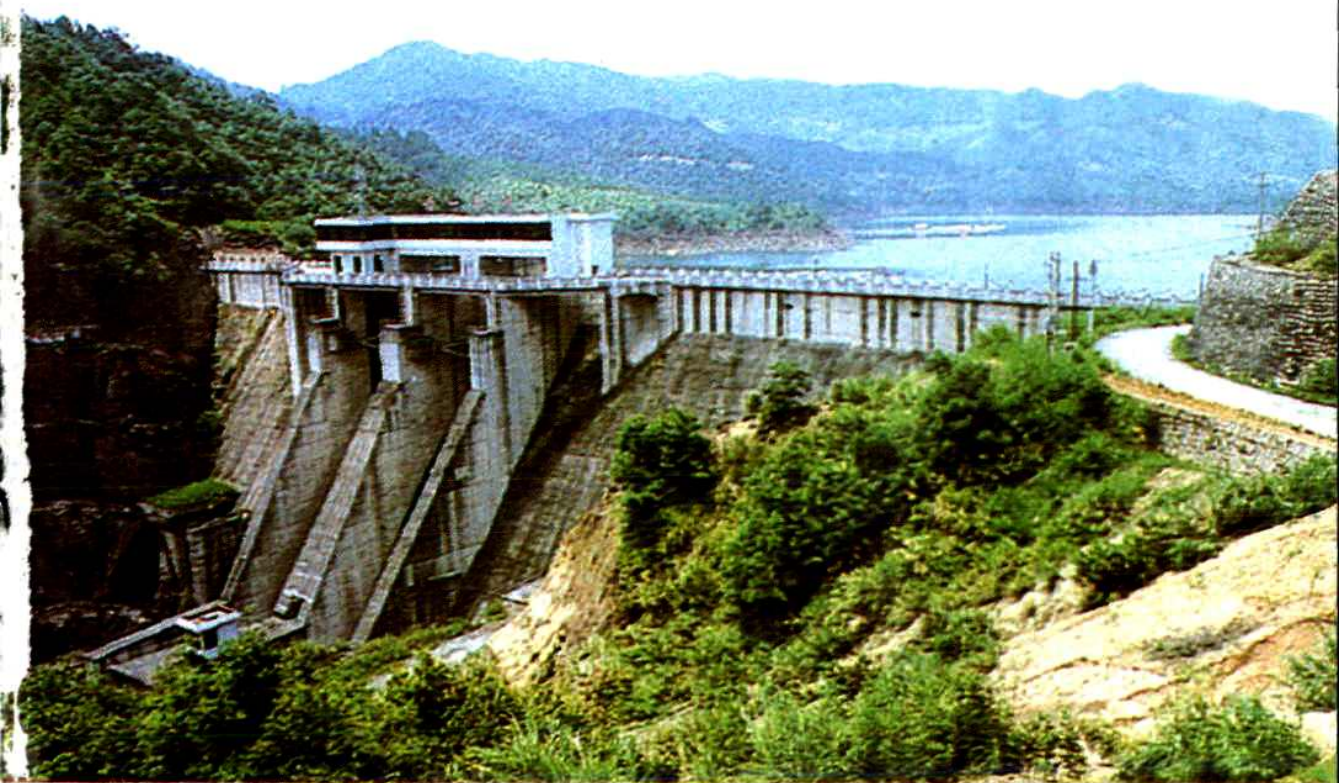
南一水库坝高 97 米，库容 1.58 亿立方米，坝后电站装机 2 万千瓦
