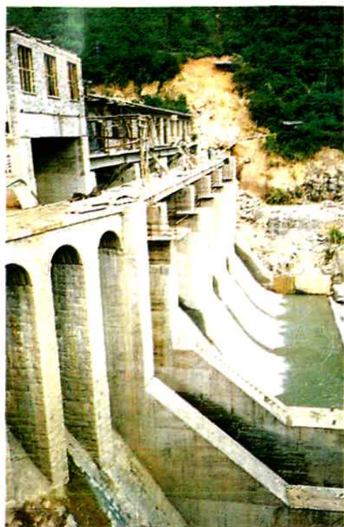
南三电站水库，砌石重力坝 高31米，库容345万立方米，水 电站装机8000千瓦
