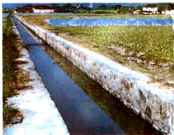
金山引水渠道，长22.5公里，灌溉1.08万亩
