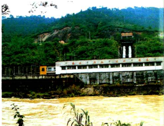
南坑(南四)水电站，装机5000千瓦
