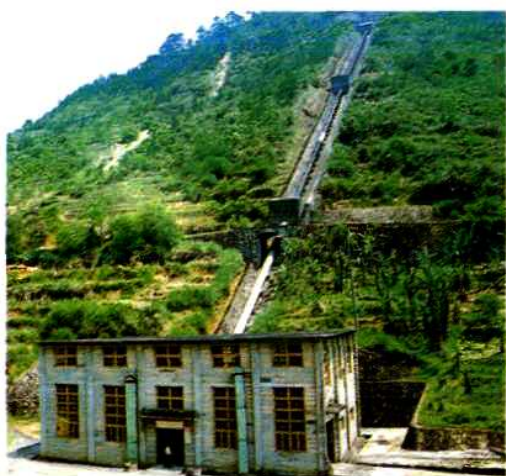
龙山梯级水电站，总装机4800 千瓦，图为二级水电站，装机2台 1600千瓦
