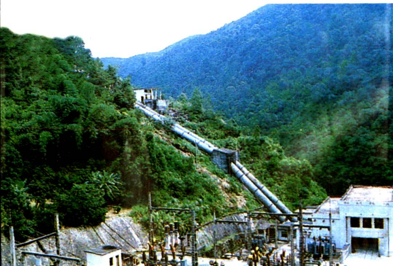
南二水电站，总装机容量 2.5 万千瓦
