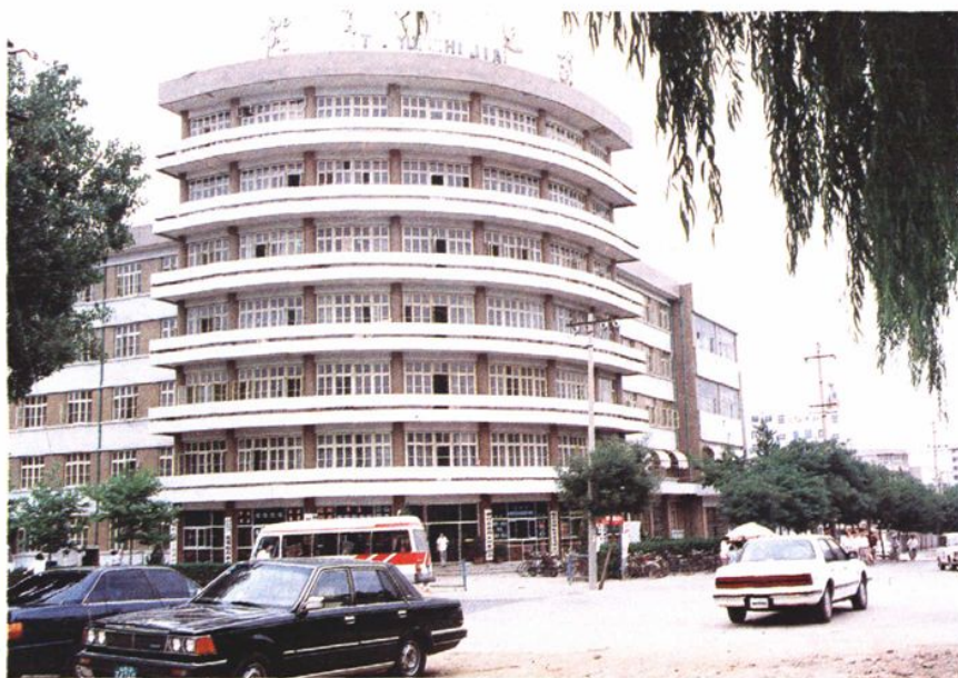
上:体育之家(烟台市体 委在三楼办公) 中:烟台体育馆 下:烟台体育场
